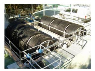
El **biodisco B22** ha sido diseñado y producido buscando ofrecer una mayor calidad y durabilidad que la serie ROTOSPIR. Ofrece los conocimientos y experiencias acumulados durante quince años en la serie B36, una mecánica muy robusta y discos termoconformados en piezas de gran tamaño. El equipo consta esencialmente de los siguientes componentes:
