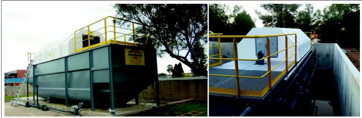
La EDAR de biodiscos modelo ND es un conjunto compacto diseñado para conseguir la eliminación de DBO5, S.S. y nitrógeno.
