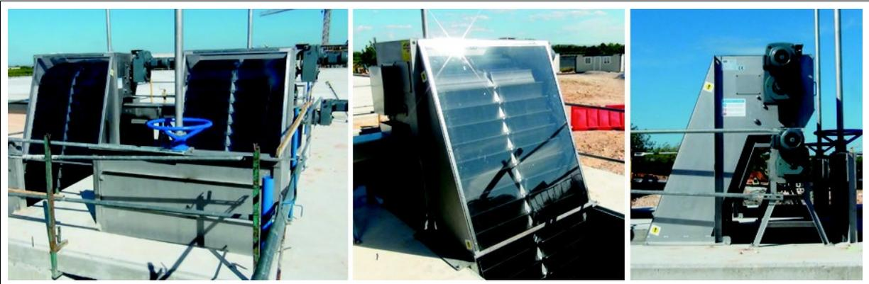
La banda filtrante del tamiz está formada por dientes en forma de nariz, construidos en ABS, engarzados uno con otro mediante ejes de acero inoxidable. Estos ejes se unen a una cadena transportadora de rodillos con pestaña y ejes huecos, que acciona todo el mecanismo.
